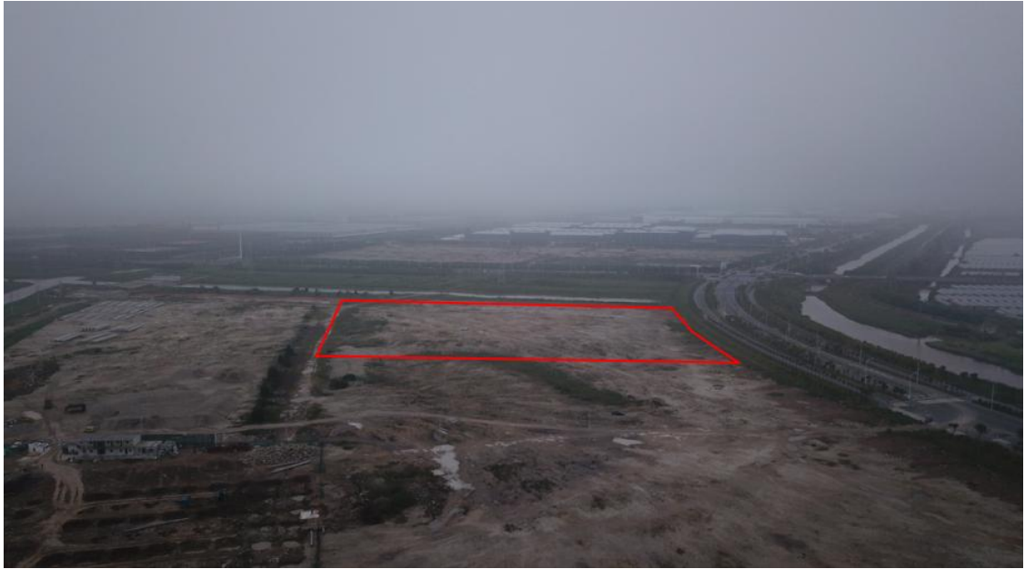
图 2-4 东部新区 2 厂区现场照片
