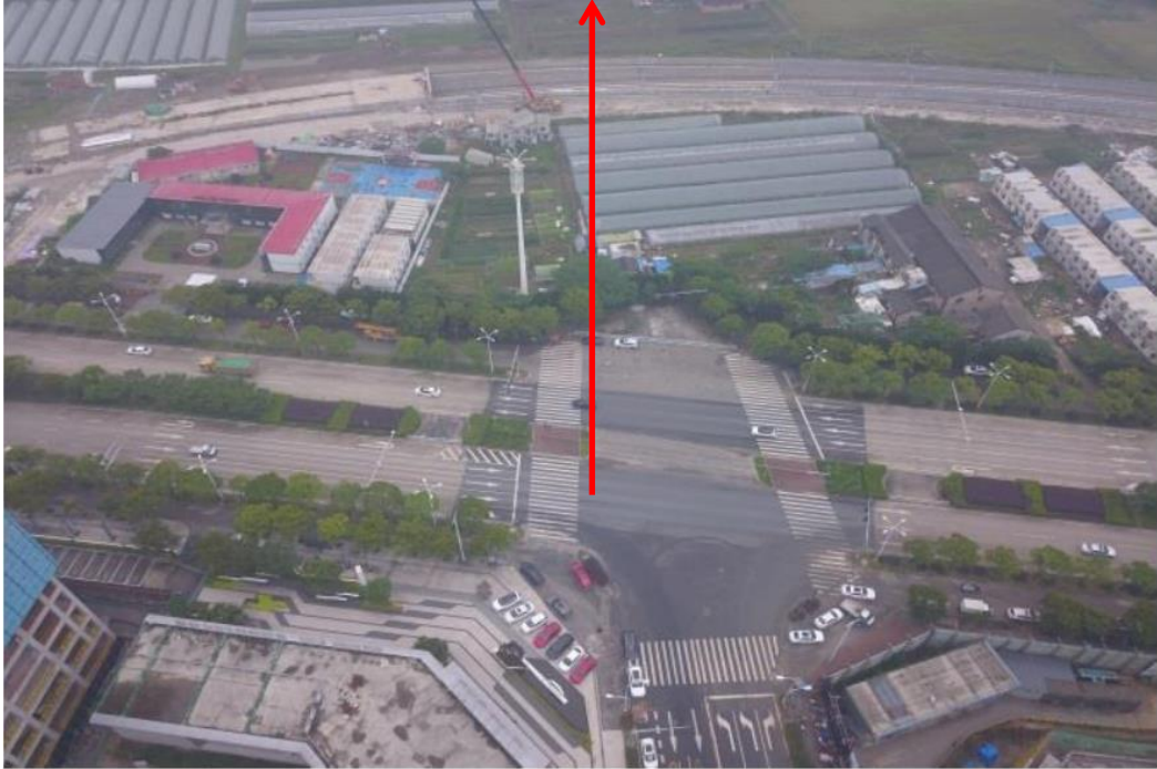
图 3-1 道路起点春潮路与中心大道交叉口现状
